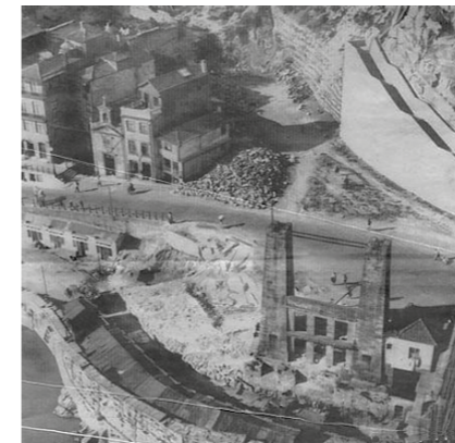
Fig. 54 Aspecto da Ribeira antes do túnel.
