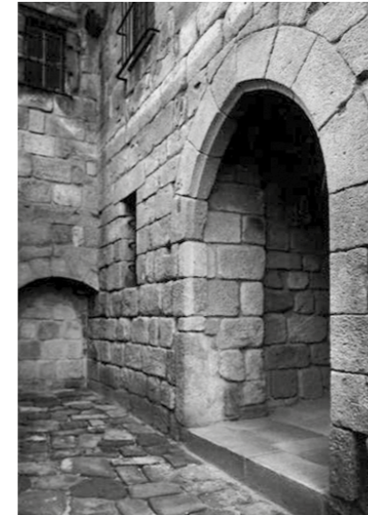
Fig. 10 Pormenor da viela que servia de ligação entre a Casa da Moeda com o túnel que servia a rua do Infante D. Henrique.
