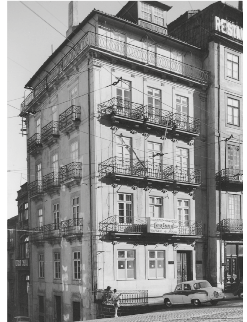
Fig. 9 Aspecto geral de um imóvel setecentista. Rua da Reboleira. Fonte: AHMP
