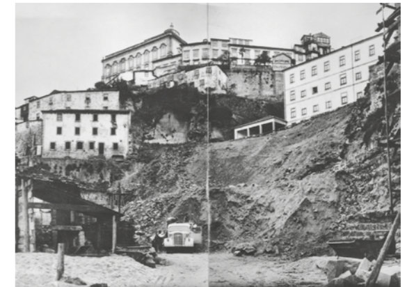
Fig. 53 Obras de abertura do túnel da Ribeira.
