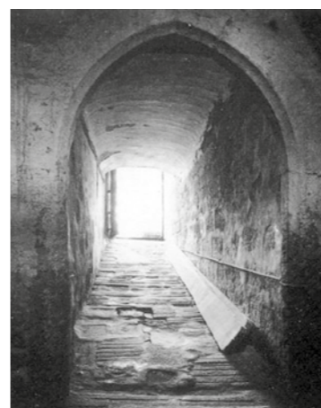
Fig. 15 Acesso pelo túnel de arco gótico até à Casa da Moeda pela Bolsa de Comerciantes. Fonte: AHMP
