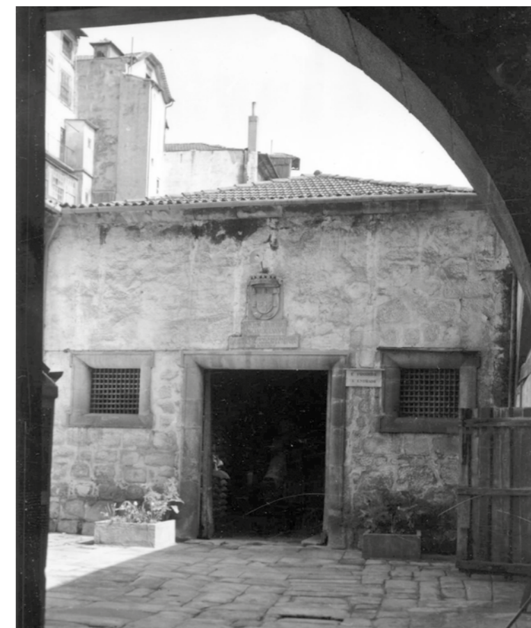
Fig. 16 Porta de entrada da Casa da Moeda, 1958. Fonte: AHMP
