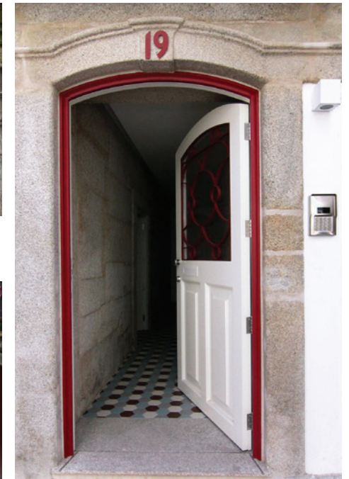
Entrada principal após intervenção
