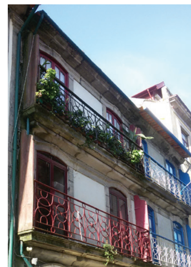
Edifício Pinheiro antes da intervenção
