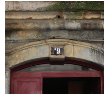
Pormenor da cantaria com pedra de fecho, antes da intervenção
