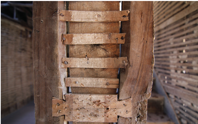
Estrutura de tabique preexistente
