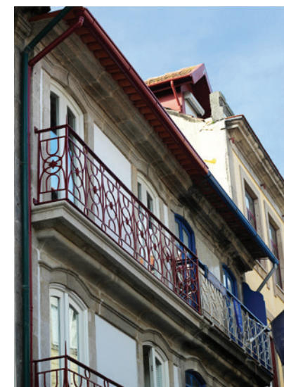
Edifício Pinheiro após a intervenção
