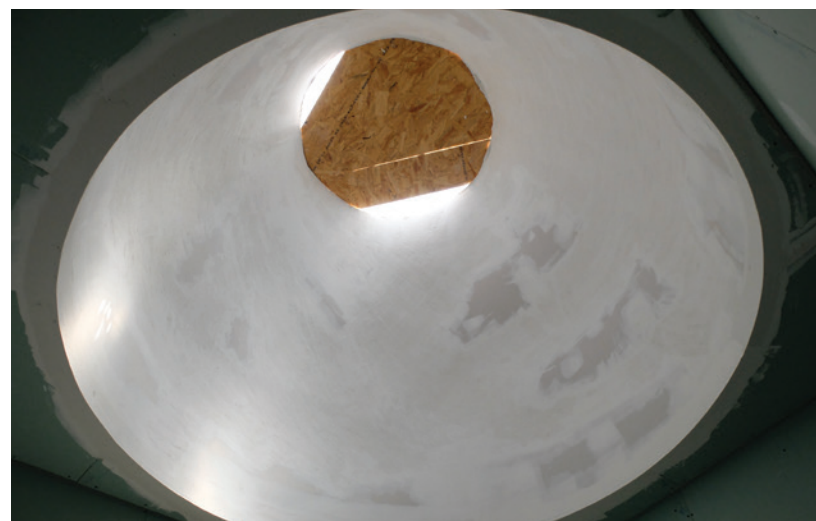
Estrutura da claraboia com cúpula
