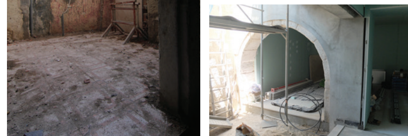
Pátio do piso 0 recuperado
