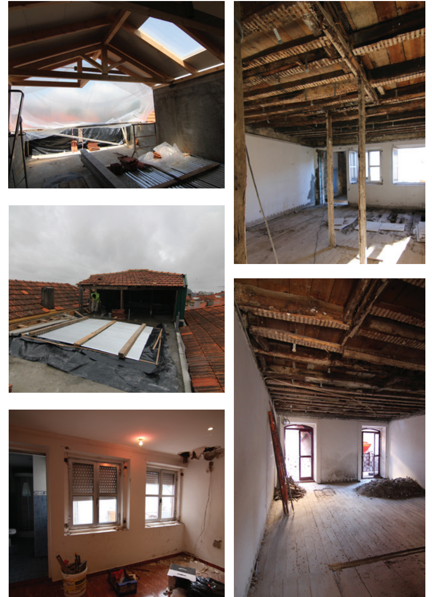
Pormenores construtivos gerais antes da intervenção
