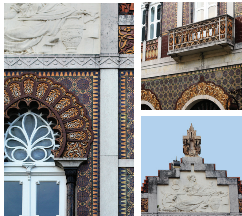
Pormenores da fachada do antigo Edifício do Depósito de Materiais da Fábrica das Devesas
