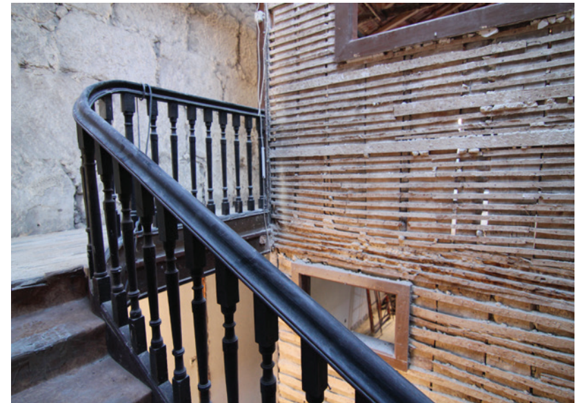
Estruturas de tabique preexistente
