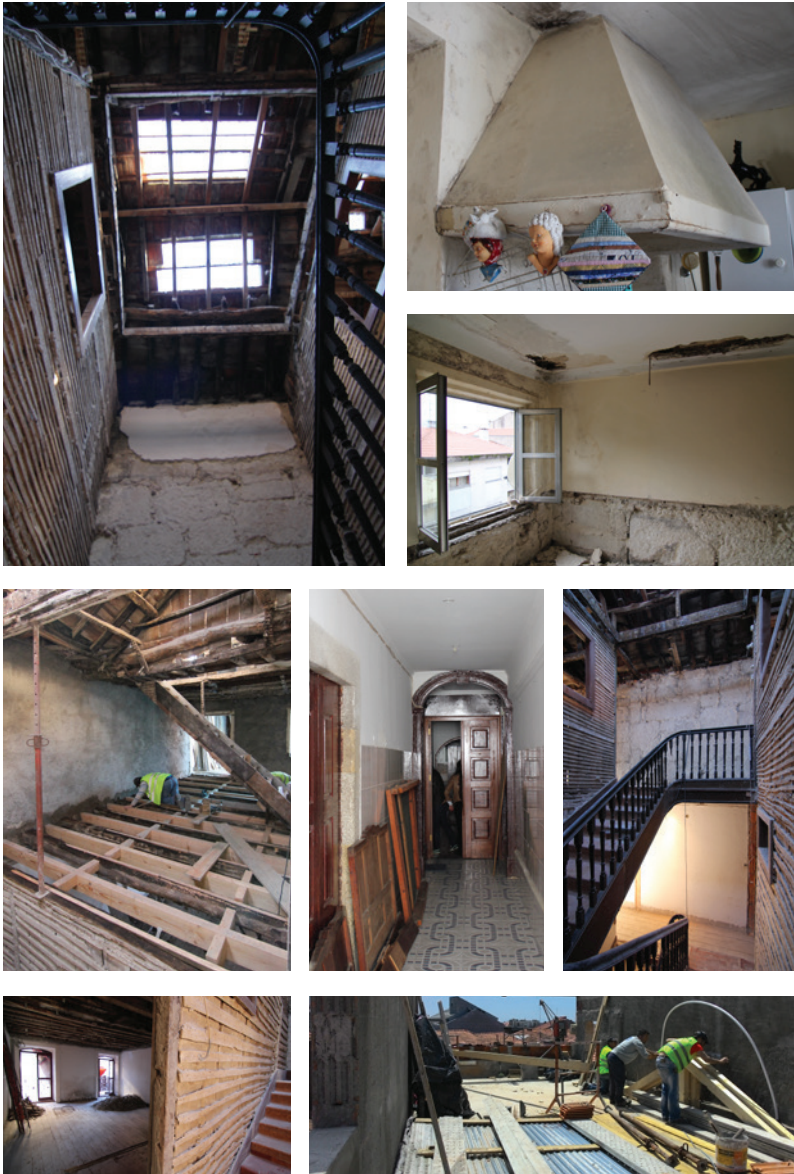
Pormenores construtivos gerais antes da intervenção
