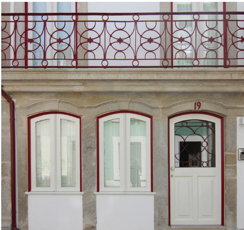
Alçado principal após intervenção do piso 0
