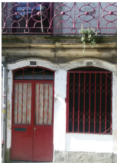
Entrada da loja antes da intervenção (vista exterior)
