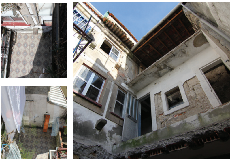
Fachadas posteriores antes da intervenção
