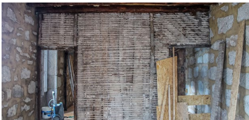
Vigas preexistentes, e tabique preexistente numa das divisões
