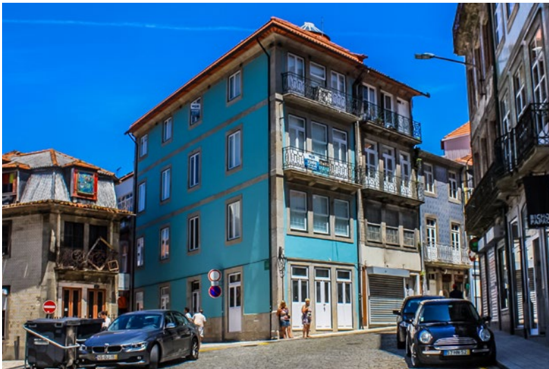
Edifício Bonjardim após a intervenção
