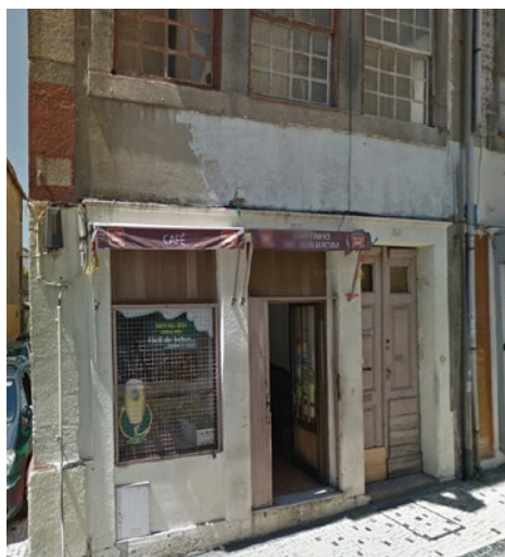
Entradas antes da intervenção
