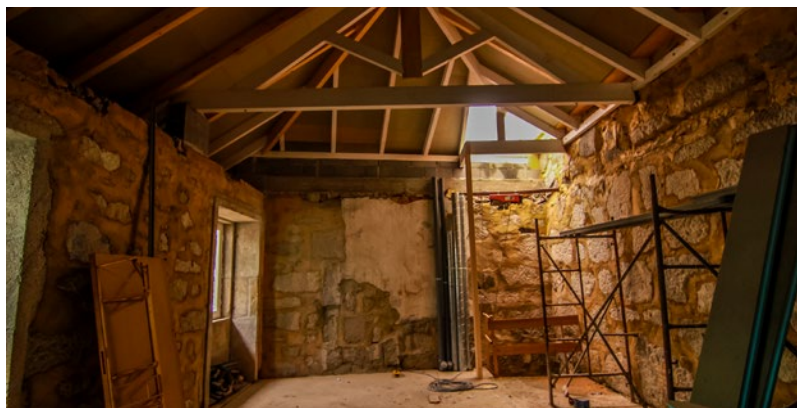
Estrutura do saguão em conjunto com a cobertura
