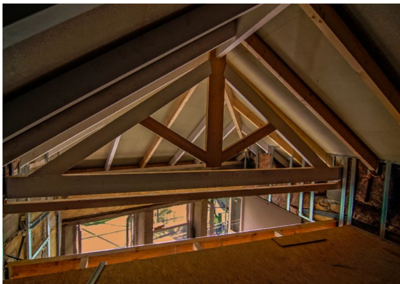
Cobertura e mezanino
