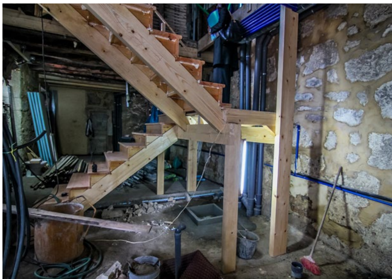
Escada antes e após intervenção
